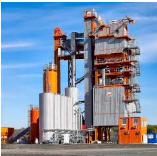
Plantas de asfalto
